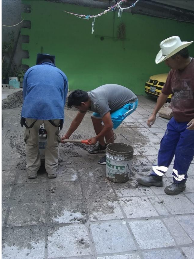
Figura 6. Familia preparando mezcla para implementar una losa de concreto.
