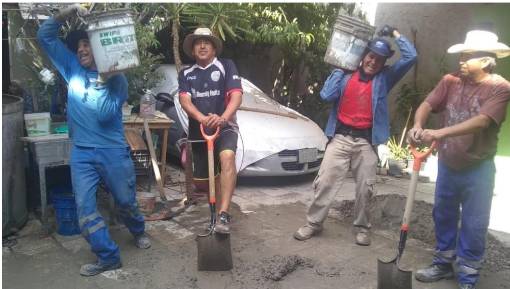
Figura 7. Familia durante trabajos de implementación de losa de concreto
